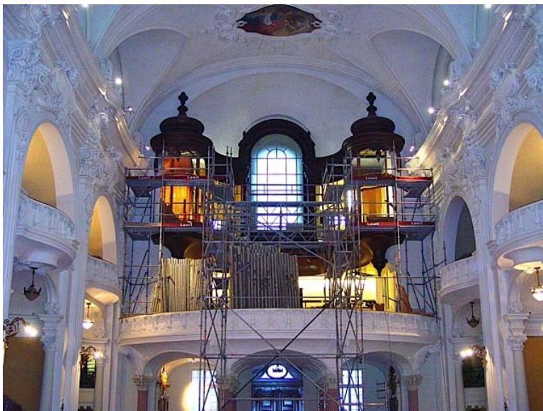
Die Orgelpfeifen werden in das Instrument wieder eingebaut
