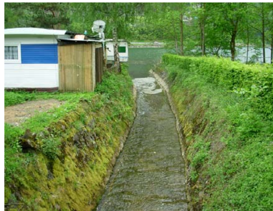
Mündung Siechenbach beim Camping Seewen
