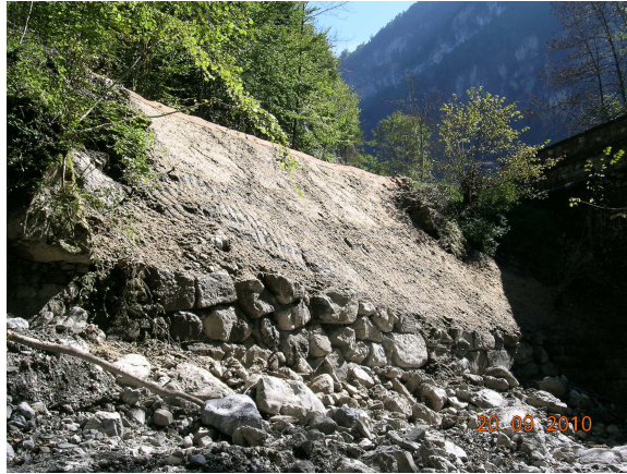
Klingentobel: Leitwerk oberhalb Brücke Kantonsstrasse instand gestellt
