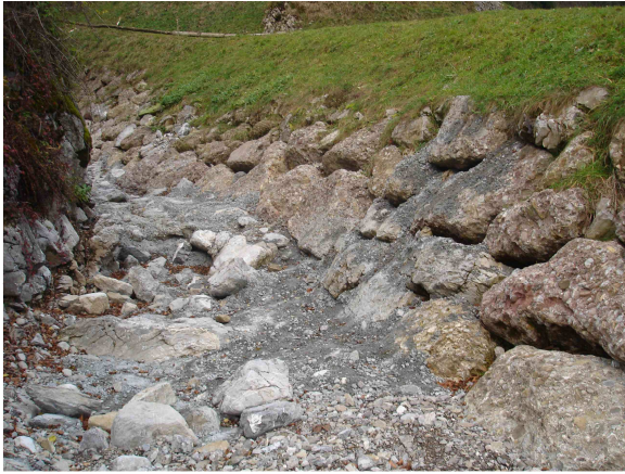
Lautobelbach: Ufer- / Sohlensicherung instand gestellt
