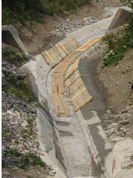
Instandstellungsarbeiten an der Wildbachschale
