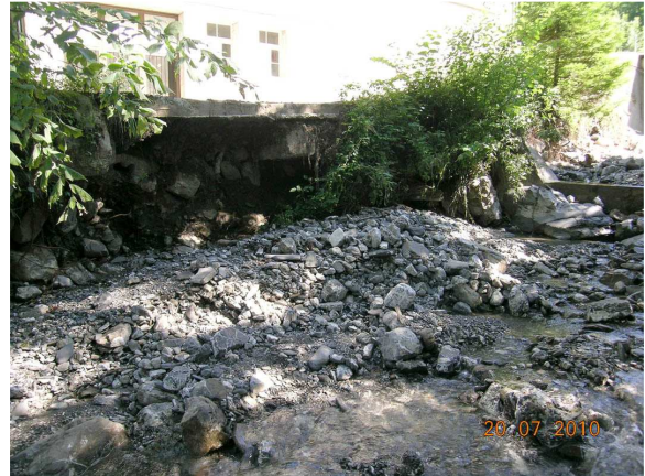
Zerstörte Ufersicherungen im Dorfbereich
