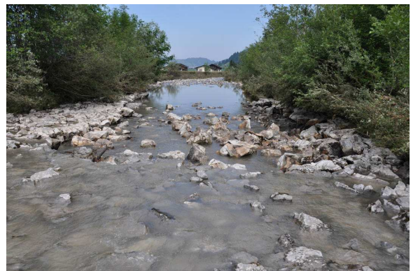
Zerstörte Sohlenpflasterung an der Sihl bei Studen
