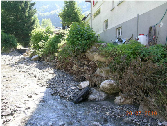
Zerstörte Ufersicherungen im Dorfbereich
