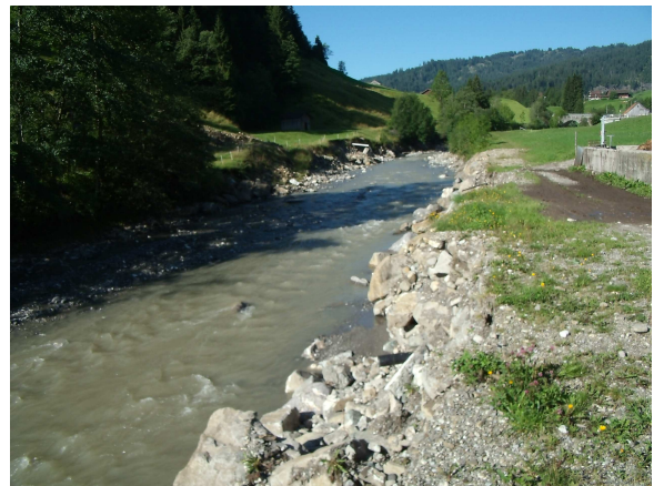
Zerstörte Ufersicherungen an der Minster bei Unterberg
