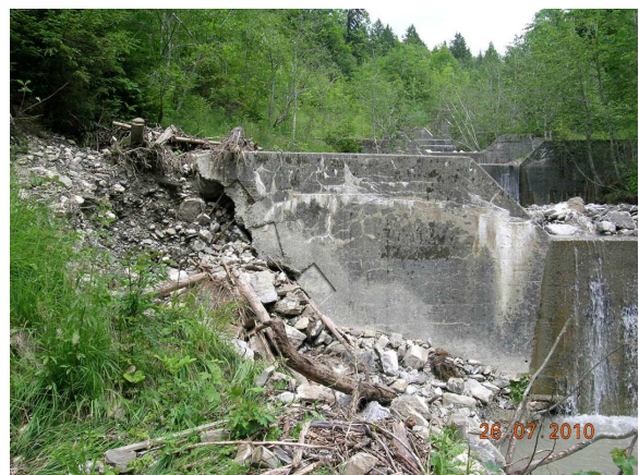
Ausgespült Sperrernflügel "Handgruobi"
