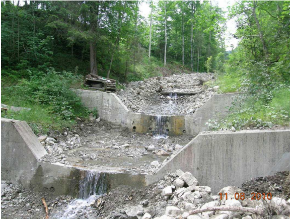
Schmalzgrubenbach: Von Geschiebe geräumter Bachlauf
