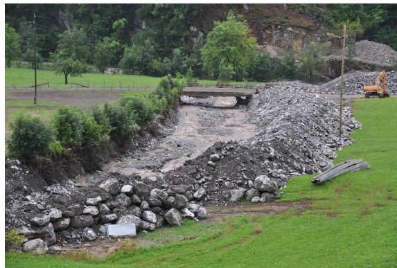
Bachlauf und Brückendurchlass geräumt
