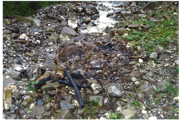
Überfüllte Sperre beim Geschiebesammler
