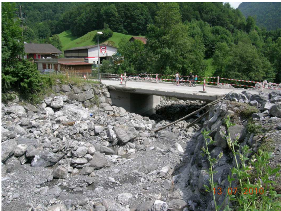
Brücke Pragelpassstrasse über Teufbach
