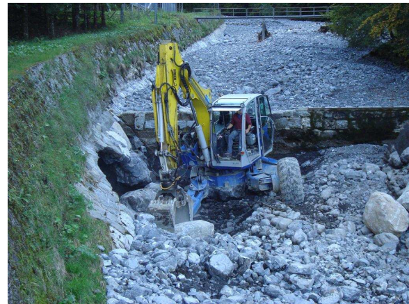
Instandstellungsarbeiten im Ochsenboden
