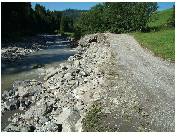
Zerstörte Ufersicherungen an der Minster bei Unterberg
