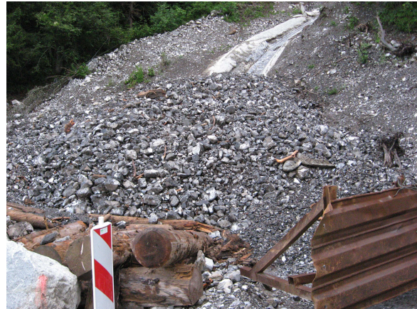
Geschiebesammler bei Riemenstaldnerstrasse
