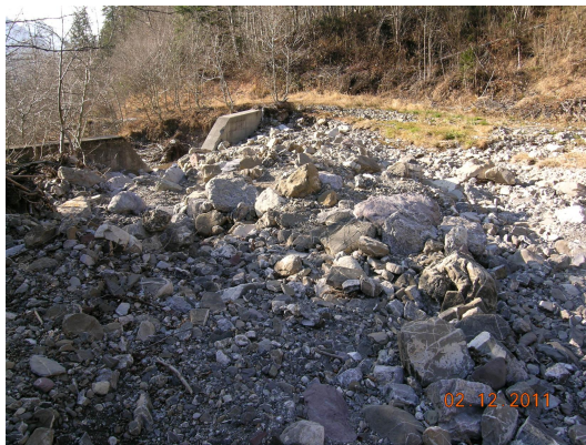
Verfüllte Sperrenbauten und beschädigte Uferpartien nach dem Ereignis vom Oktober 2011
