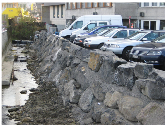
Neu erstellte Ufermauer bei Areal „Central Gate“
