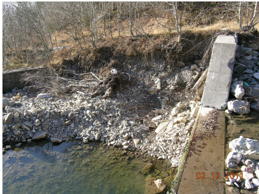
Verfüllte Sperrenbauten und beschädigte Uferpartien nach dem Ereignis vom Oktober 2011
