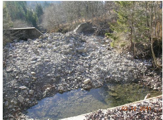
Verfüllte Sperrenbauten und beschädigte Uferpartien nach dem Ereignis vom Oktober 2011
