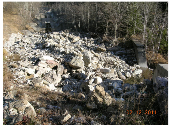
Verfüllte Sperrenbauten und beschädigte Uferpartien nach dem Ereignis vom Oktober 2011
