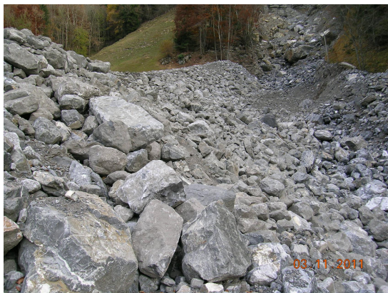
Ufersicherung rechts verlängert unterhalb des Ablenkdamms
