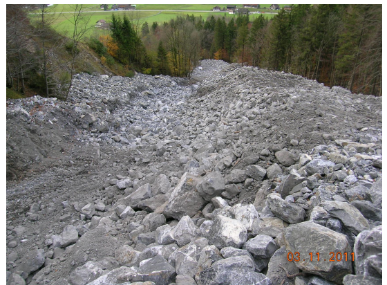
Ufersicherung rechts verlängert unterhalb des Ablenkdamms
