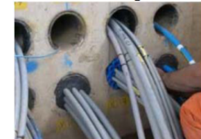
Abdichtung von Kabel- und Rohrdurchführungen
