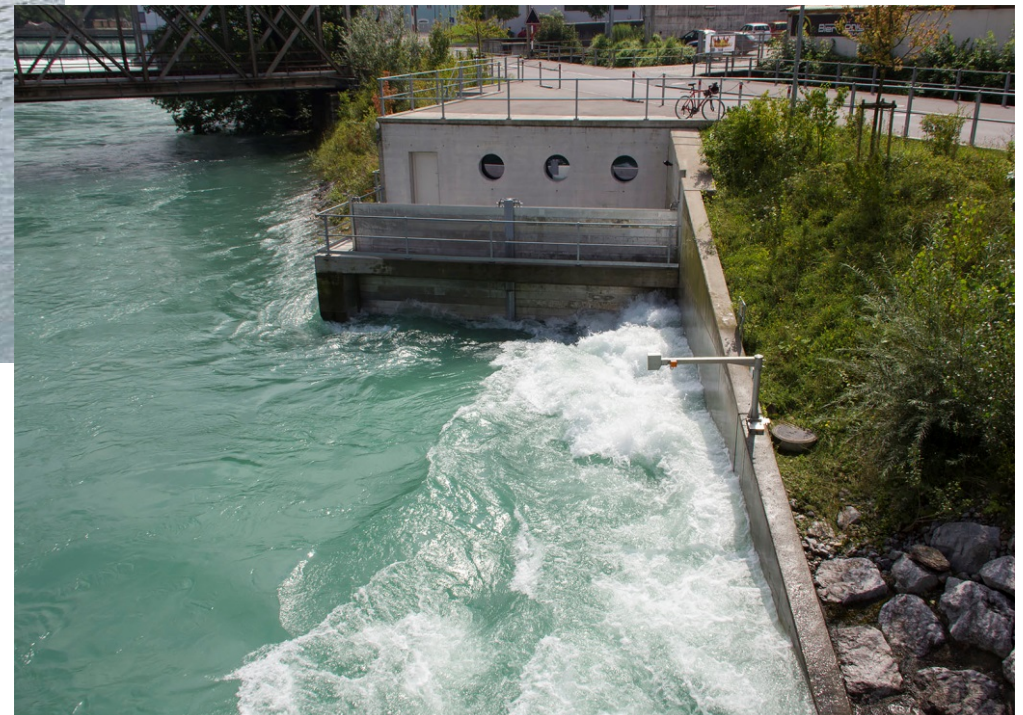
Bsp.: Auslaufbauwerk Hochwasserentlastungsstollen Thun
