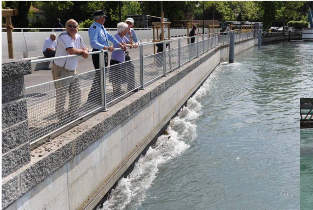
Bsp.: Einlaufbauwerk Hochwasserentlastungsstollen Thun
