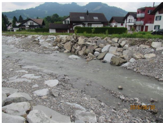
Ufersicherung rechts unterhalb Kantonsstrassenbrücke
