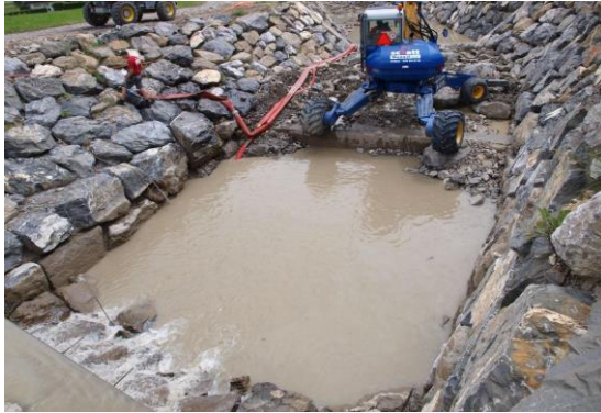
Beschädigter Sperrenkolk
