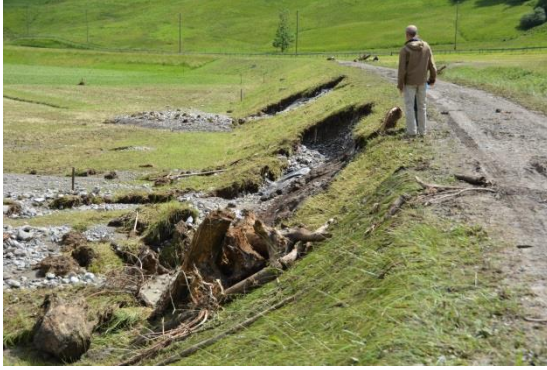
Uferdamm Minster/Nidlaubach nach Ereignis und während Wiederaufbau
