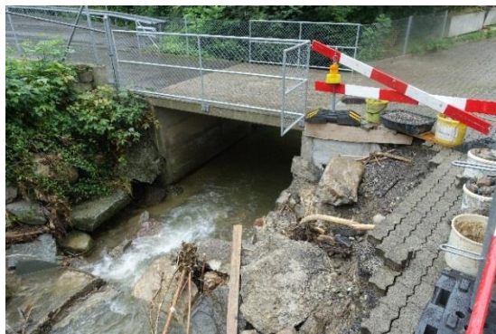
Krebsbach Ufermauer Verena Hof
