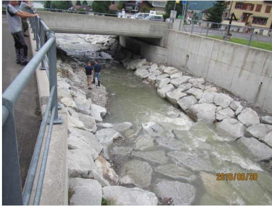
Raugerinne Bereich Kantonsstrassenbrücke
