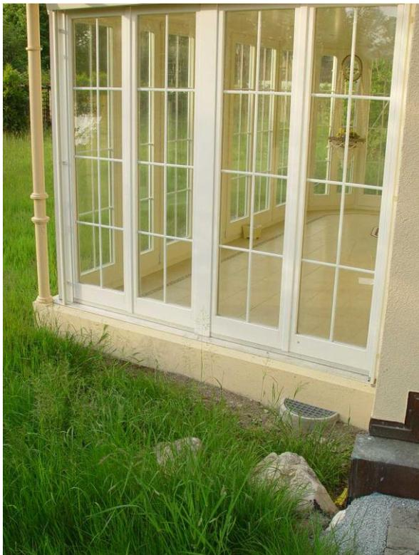
Separate Luftfassung mit aussenliegendem Schacht inkl. Gitterrostabdeckung
