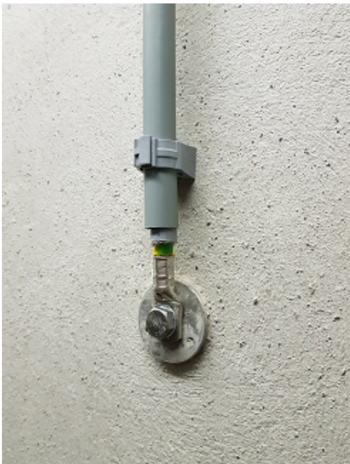
Figur 14 Nachträglicher Einbau der Anschlussstelle ZS für den Schutzpotenzialausgleich
