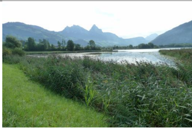
Inhalt: Das Einlaufbauwerk liegt im Naturschutzgebiet.
