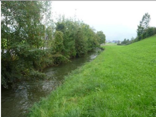
Inhalt: Abschnitt direkt unterhalb Restaurant Bauernhof mit Aufweitung rechts (Blick in Fließrichtung)
