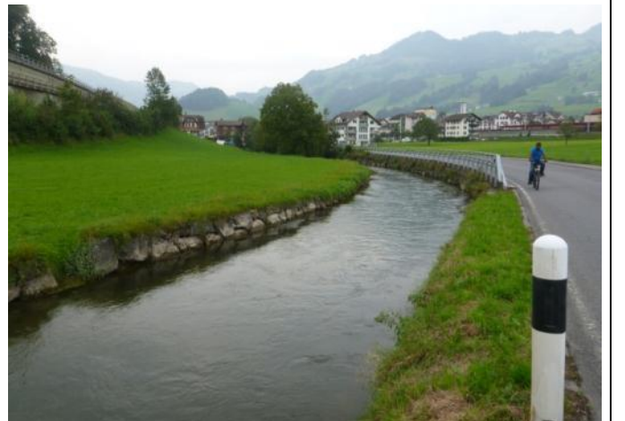
Inhalt: Bereich Auslaufbauwerk Urmibergstollen "kurz"
