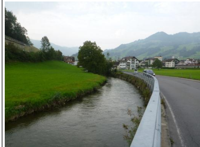
Inhalt: Bereich Auslaufbauwerk Bypass
