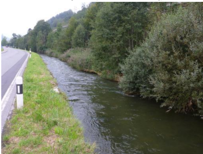
Inhalt: Abschnitt mit Verlegung der Strasse, Aufweitung links (Blick in Fließrichtung)
