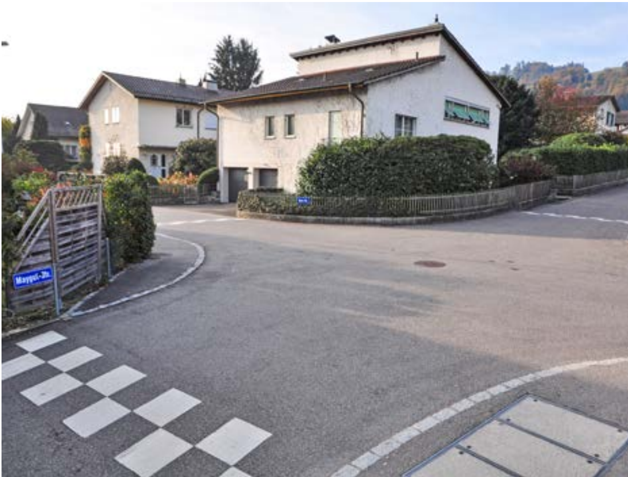
Abbildung 13: Vertikalversatz als Aufpflasterung einer ganzen Kreuzung
