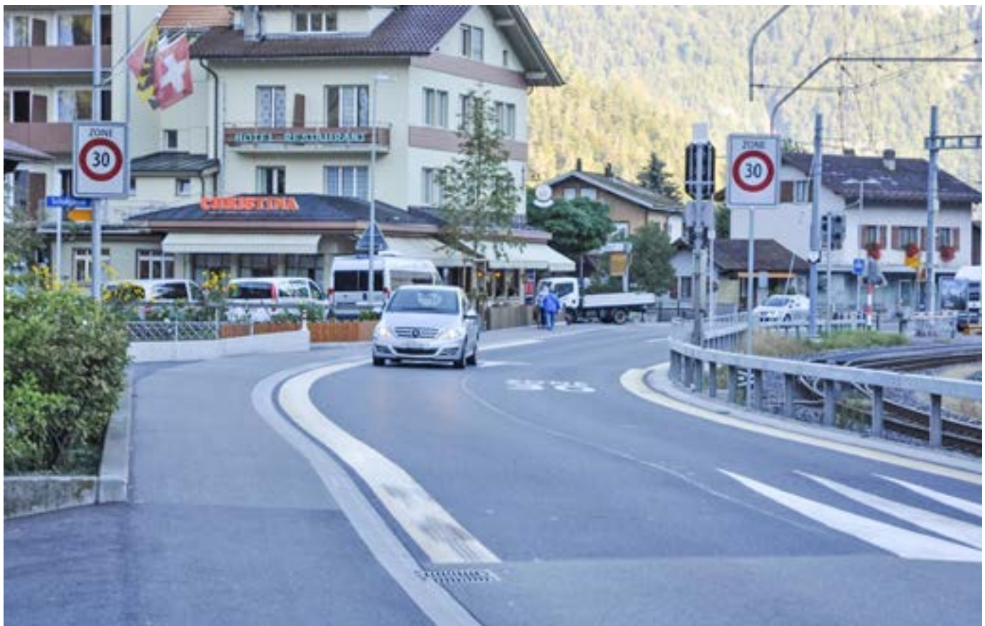
Abbildung 2: Torelement beim Übergang «Generell 50» – «Tempo-30-Zone» auf dem übergeordneten Netz
