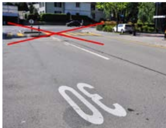
Abbildung 8: Zonenfremde Elemente – überbreite Fahrbahn, Fussgänger-Schutzinsel, Fussgängerstreifen
