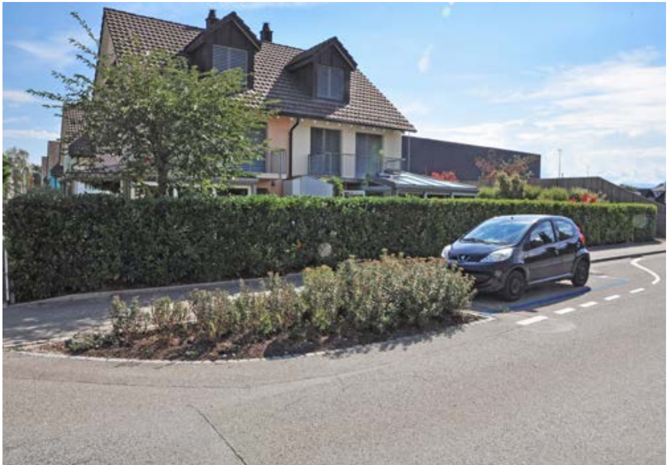
Abbildung 15: Baulicher Abschluss eines Parkfeldes
