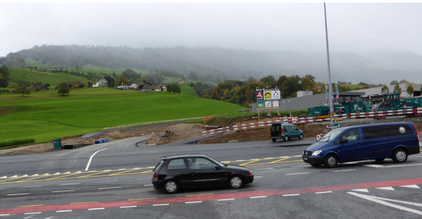
Neue Baustellenzufahrt Luterbach in Betrieb, 7.10.2015
