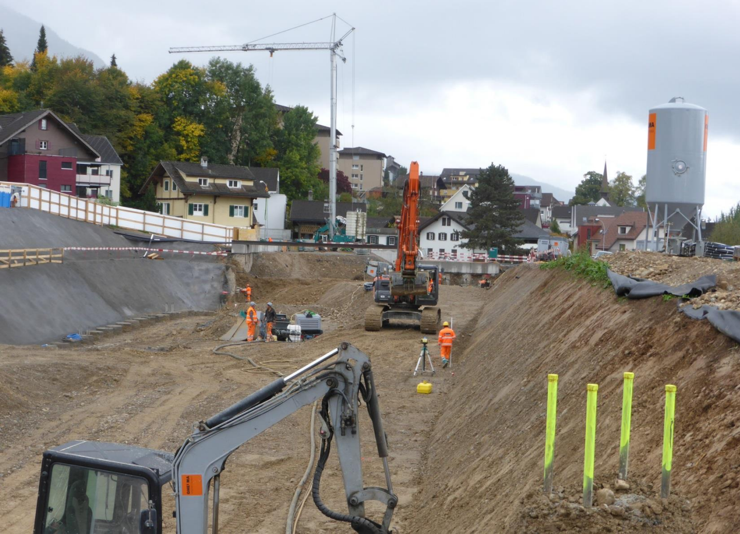
Der Voreinschnitt startklar für den Aushub, 7.10.2015
