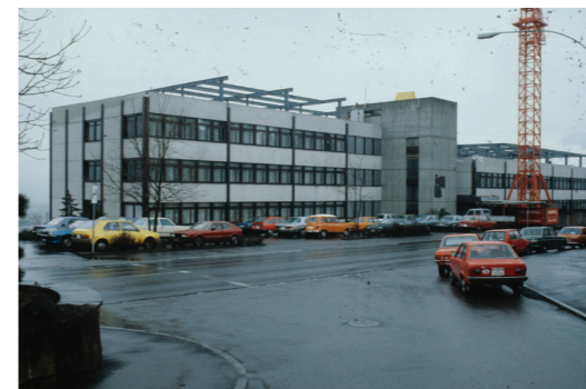
Baustelle des AHV-Gebäudes, späte 1960-er Jahre
