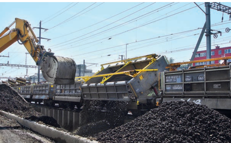
Abb. 19: Schotterentsorgung Gleisbau, Foto © AfU
