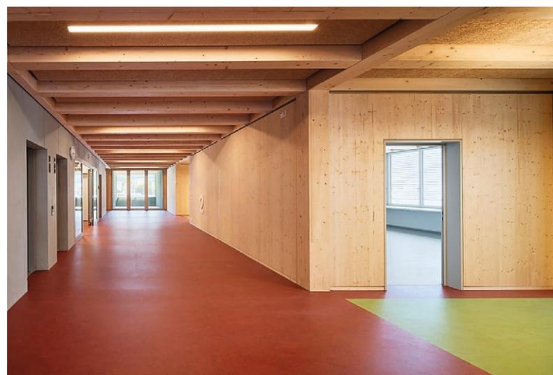
Der Minergie-A-Neubau des Heilpädagogischen Zentrums in Ibach wurde in Holz-Elementbauweise mit Schwyzer-Holz in rund 21 Monaten geplant, realisiert und eingerichtet.
