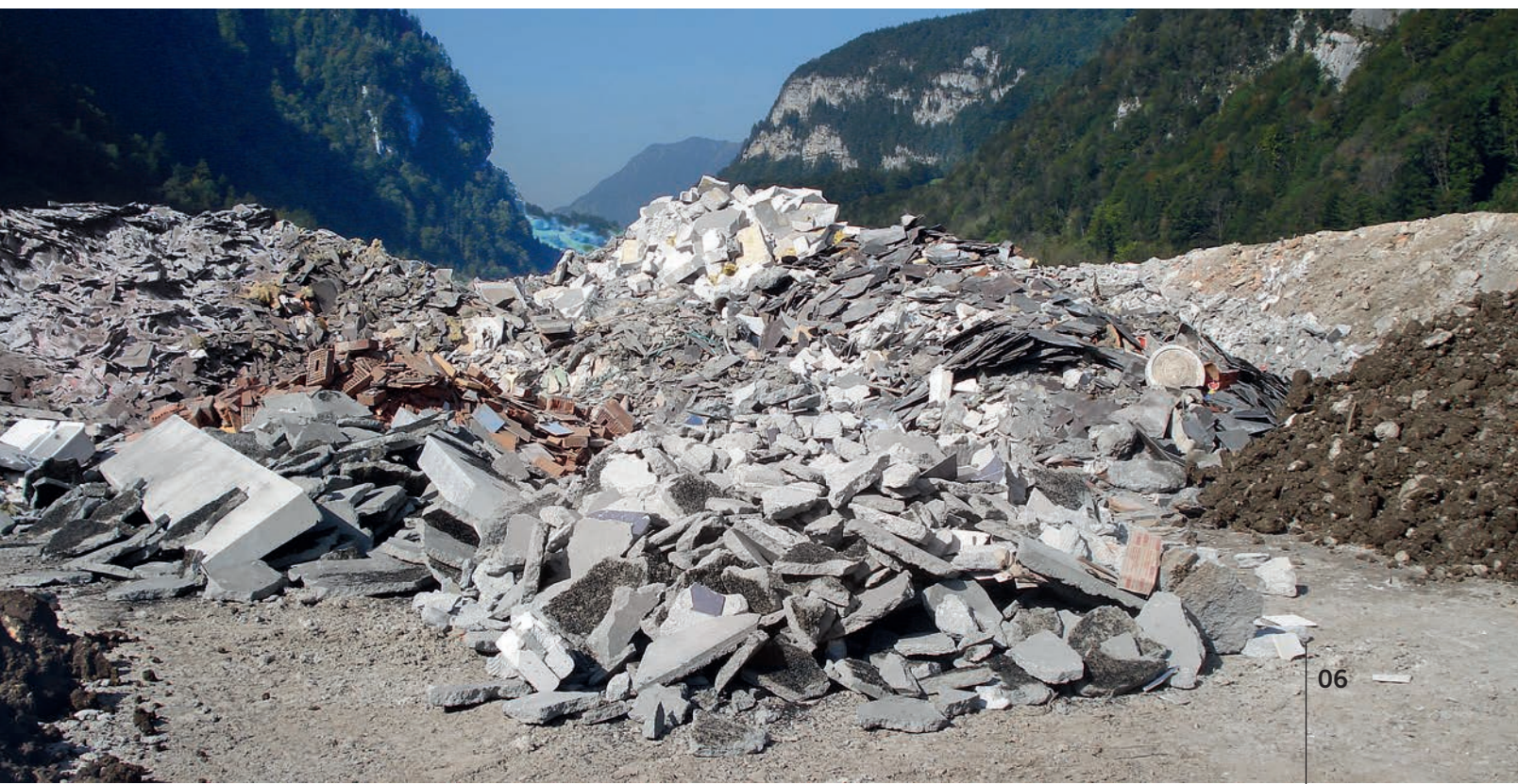
Foto 5: Ablagerung von Bauschutt auf der Deponie Typ B «Selgis» in Muotathal.
