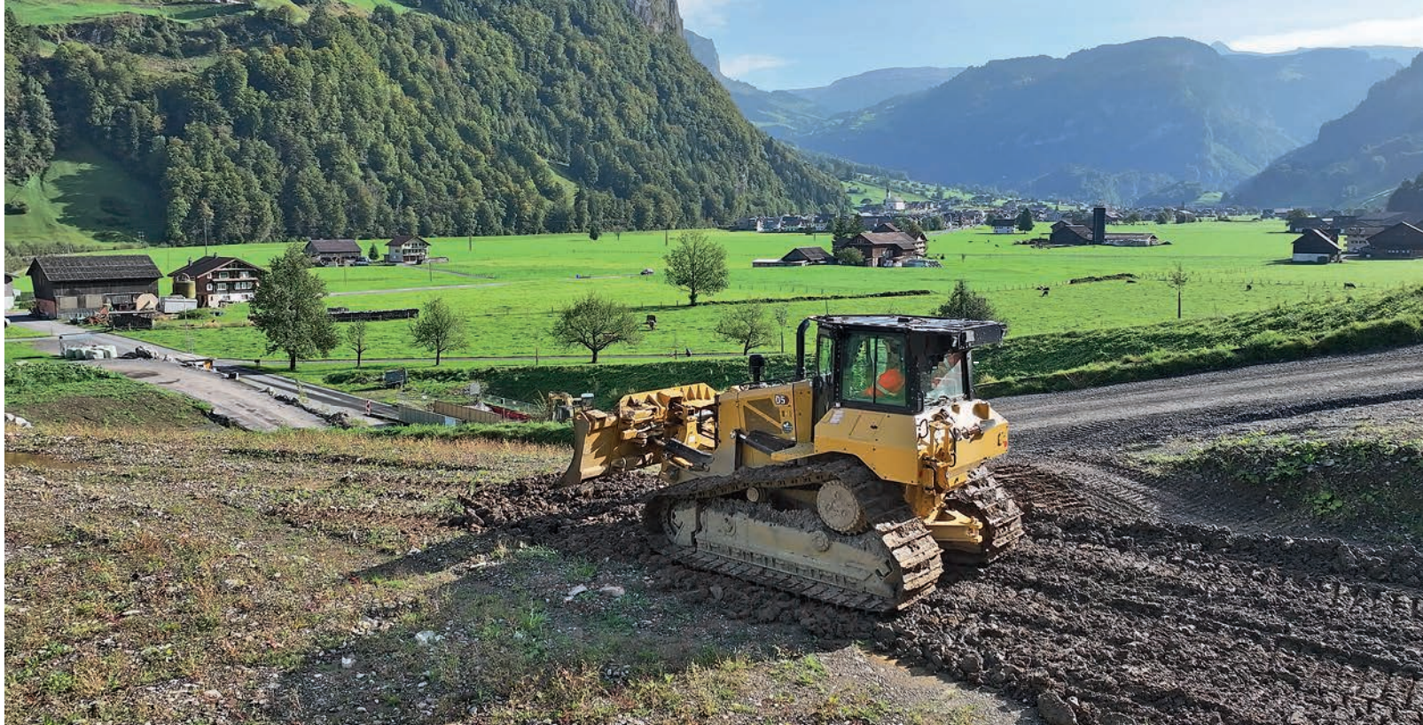
Foto 6: Raupenfahrzeug zur gleichmässigen Verteilung des angelieferten Aushubs.
