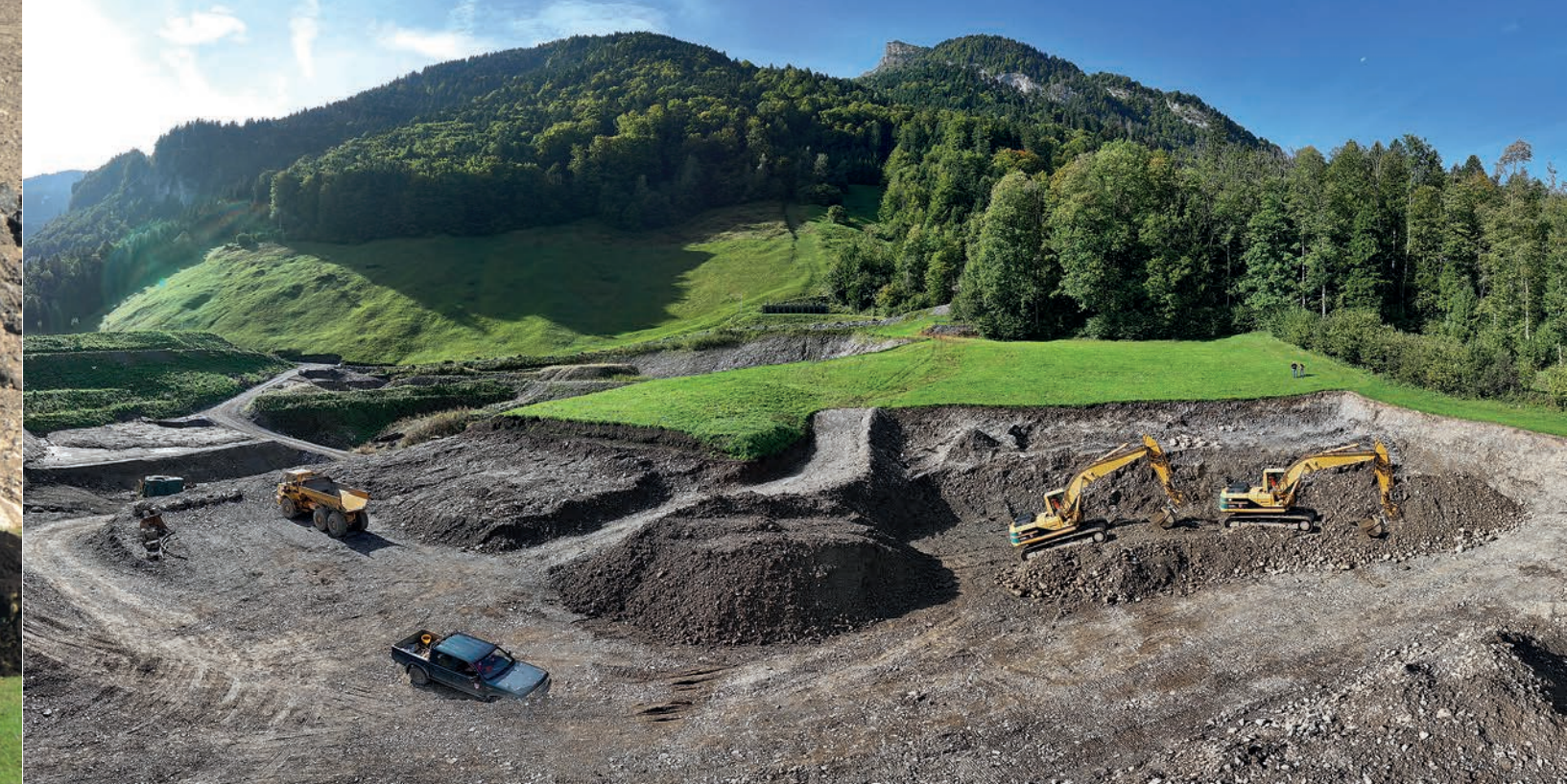
Foto 3: Ablagerung von unverschmutztem Aushub, Deponie Typ A «Lustnau» in Muotathal.
