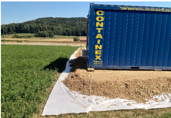
Bodenschutzmassnahmen bei temporären Bauinstallationen (Fotos: Corinne Schmidiger, Basler & Hofmann AG und Dominik Müller)
