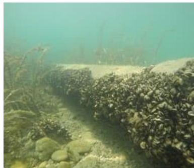
Quaggamuscheln an Rohr (L. Haltiner, Eawag)
