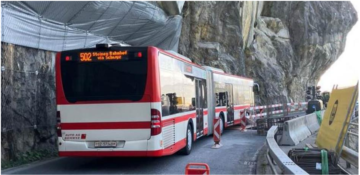
Abbildung 7: Buslinie 502 Küssnacht - Schwyz - Arth passiert die Baustelle bei der Nas in Vitznau
